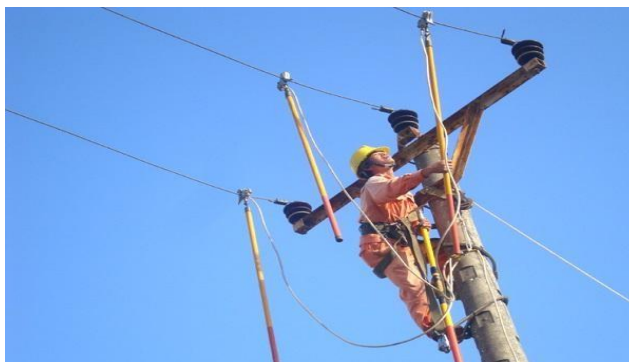
Hình 1.7: Sử dụng dây an toàn khi làm việc trên cao
