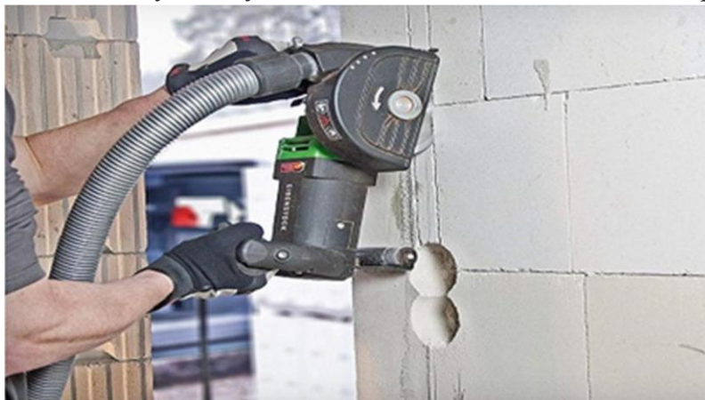
Hình 1-19. Kỹ thuật cầm máy cắt rãnh tường
