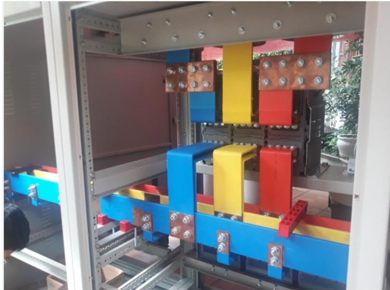
Hình 3-4. Thanh cái đồng được gia công và lắp ráp
